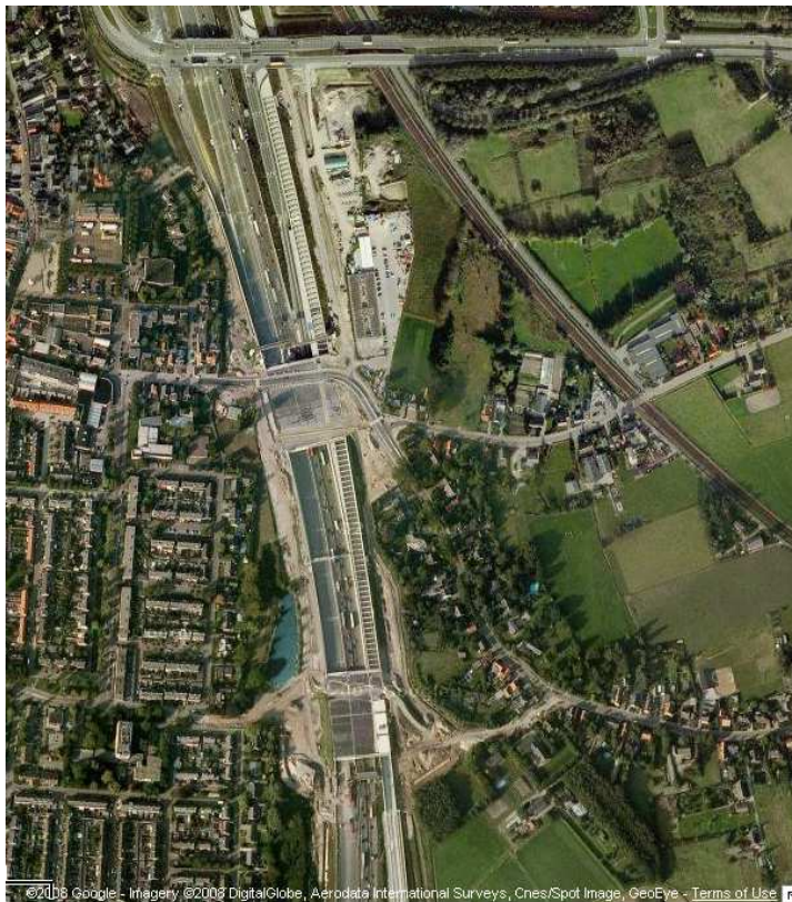
Figuur 3. Prinsenbeek, de A16 in een tunnelbak omdat de HSL verdiept 'moest' worden aangelegd.
