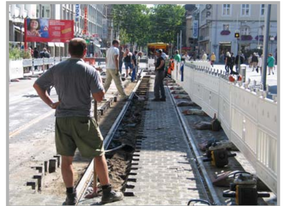
Figuur 5 Installatie van prefab-systeem (links) en traditioneel systeem (rechts)
