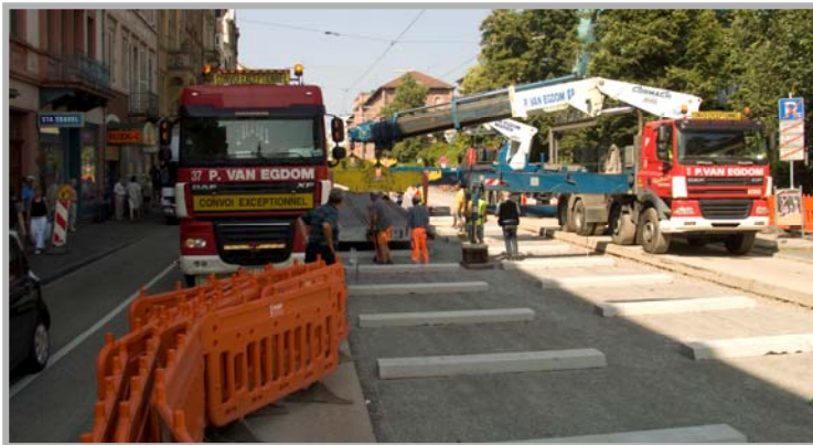
Figuur 5 Installatie van prefab-systeem (links) en traditioneel systeem (rechts)
