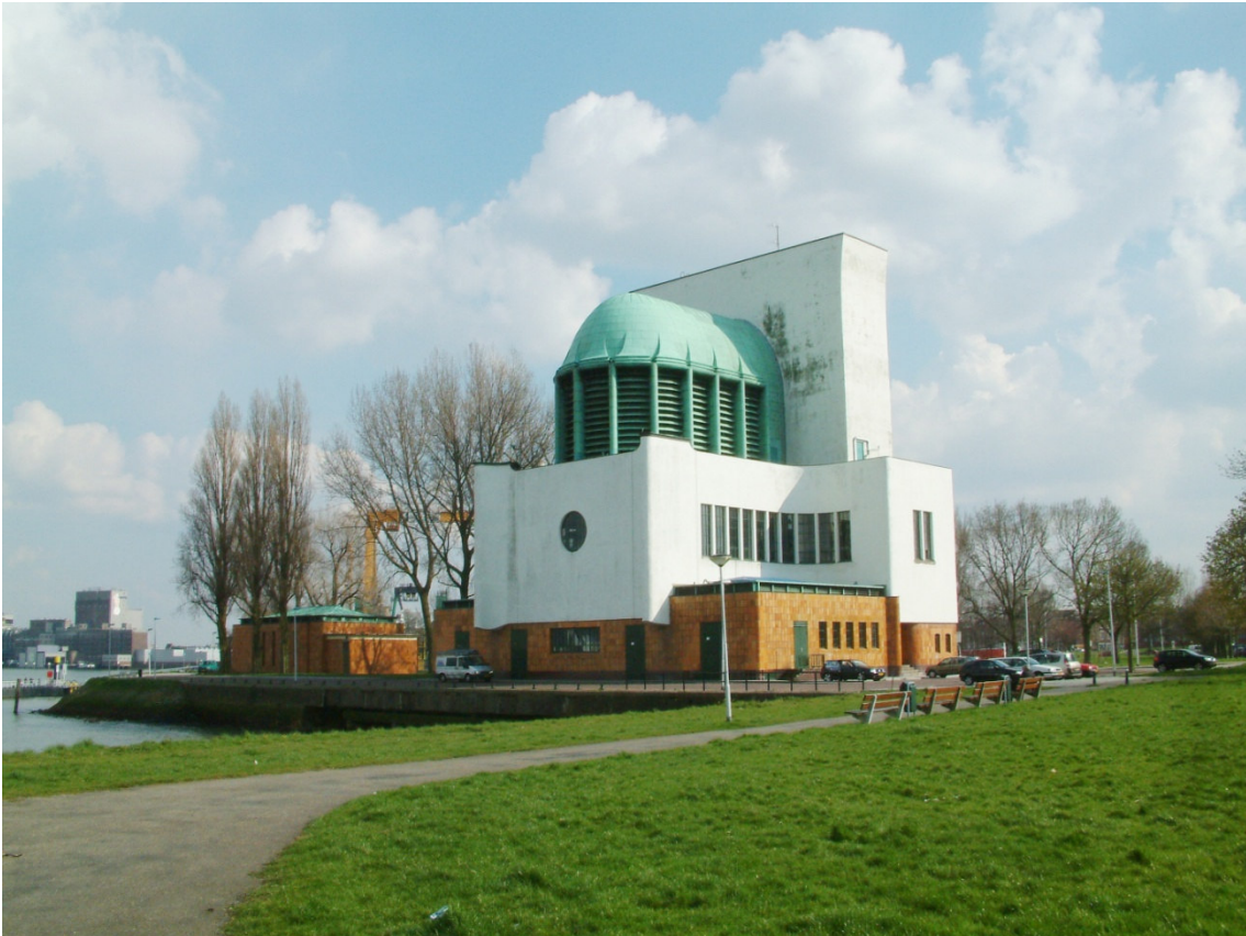
Ventilatiegebouw Maastunnel (ontworpen door Ad van der Steur) Bron: SJ de Waard
