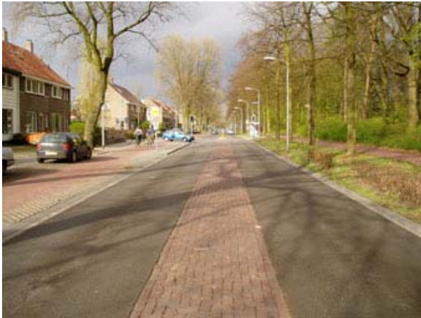
Nijmegen, rijbaanscheiding door rammelstrook
