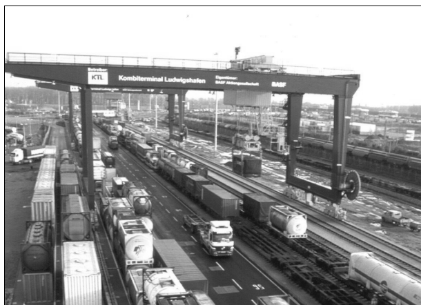
Figuur 3. De road-rail terminal van KombiVerkehr in Ludwigshafen
