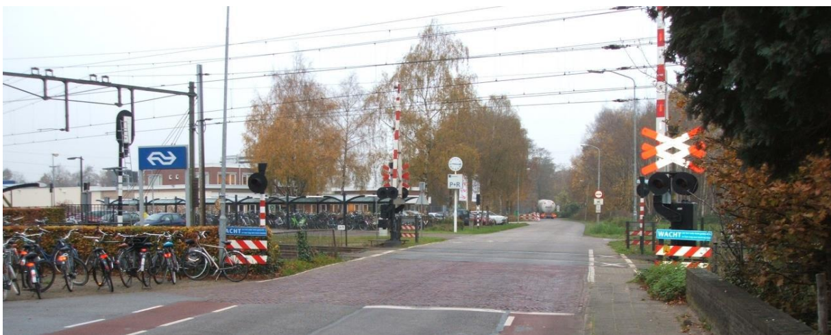
Figuur 4. Ruimtelijke context overweg (foto ARCADIS).
